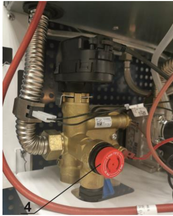
Рис. 22 Демонтаж предохранительного клапана
