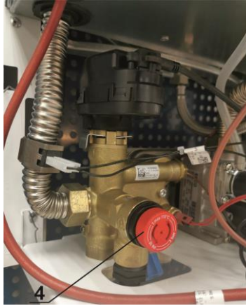
Рис. 22 Демонтаж предохранительного клапана
