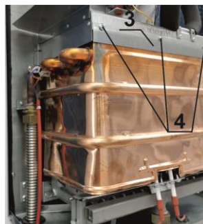
Рис. 16. Демонтаж труб и теплообменника
