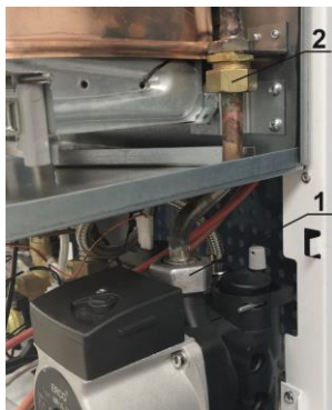
Рис. 17. Демонтаж трубы насоса
