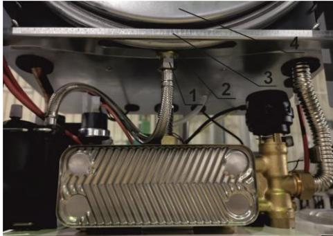
Рис. 23. Демонтаж трубы расширительного бака
