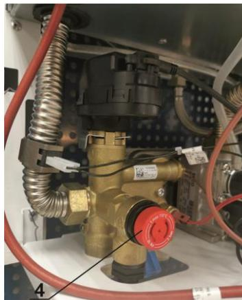
Рис. 25 Демонтаж предохранительного клапана
