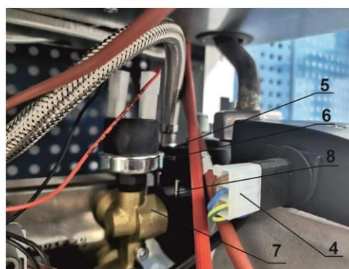
Рис. 21. Демонтаж насоса
