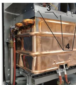
Рис. 19. Демонтаж труб и теплообменника
